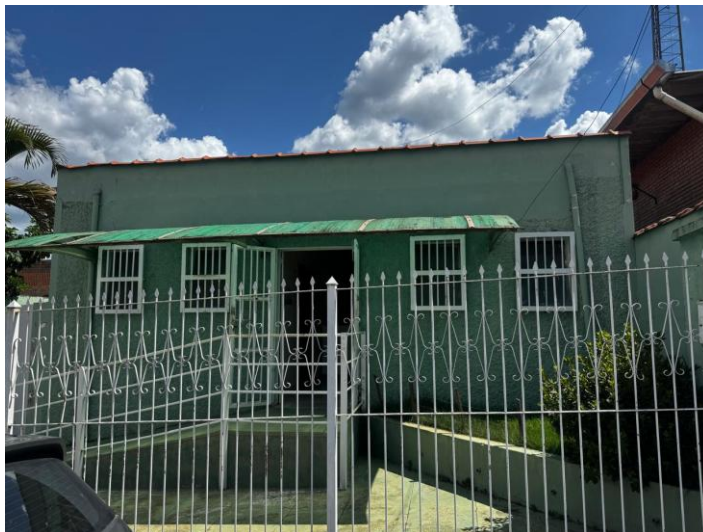
Imagem 05 – Secretaria antes do início das obras.
