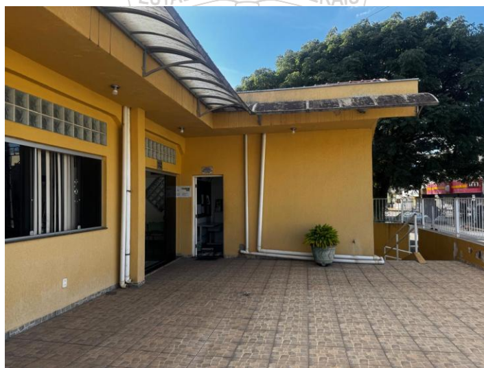
Imagem 02 – Parte interna Antes da reforma.
