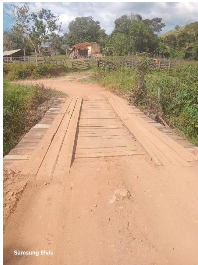
Imagem 09 – Reconstrução da Ponte “José Nivaldo”
