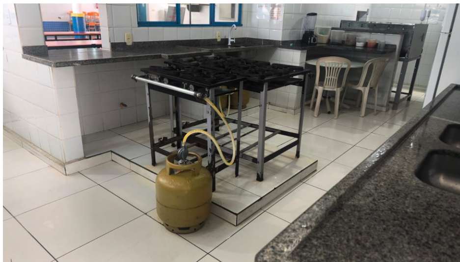
Imagem 06 – Sistema de gás antes da adequação.
