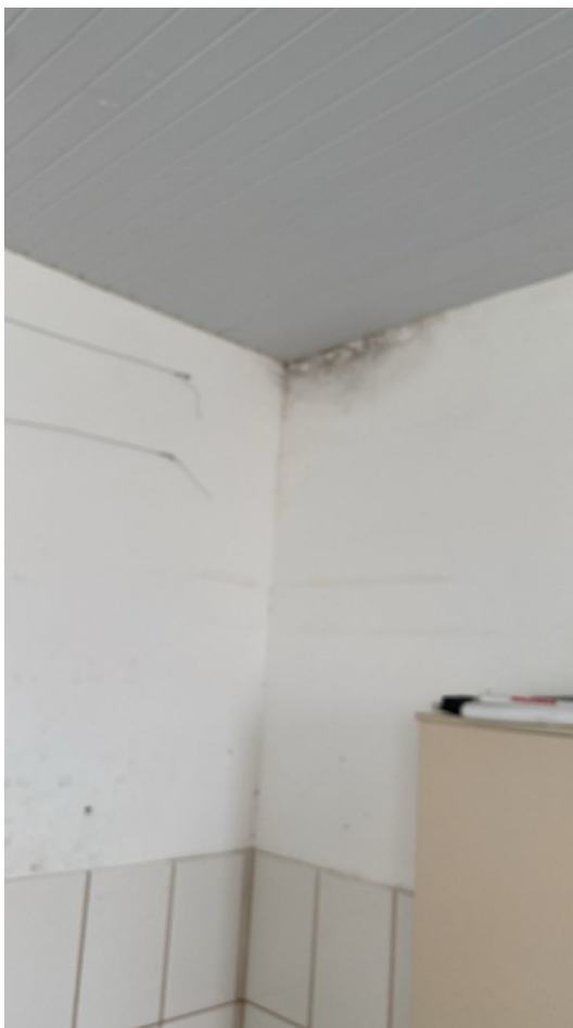
Imagem 03 – EMEF antes da pintura.
