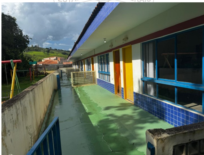
Imagem 02 – CMEI antes da reforma
