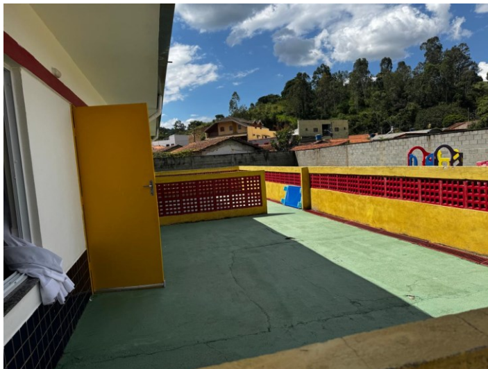
Imagem 05 – CMEI após os reparos.
