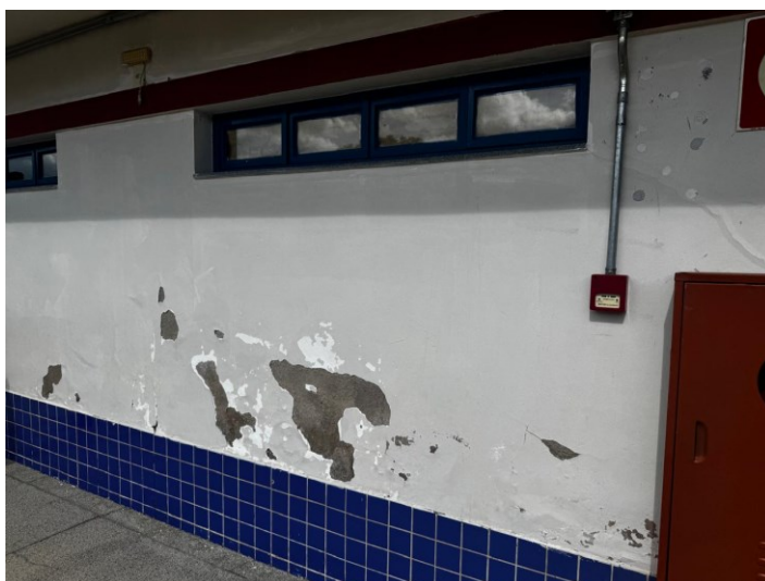
Imagem 01 – CMEI antes da reforma.
