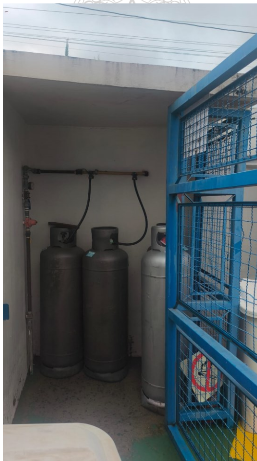
Imagem 07 – sistema de gás após a adequação.
