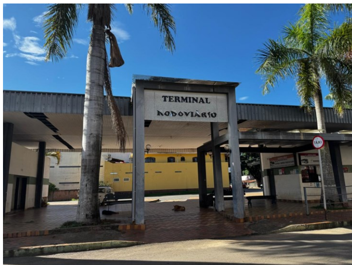
Imagem 08 – terminal rodoviário antes da reforma.
